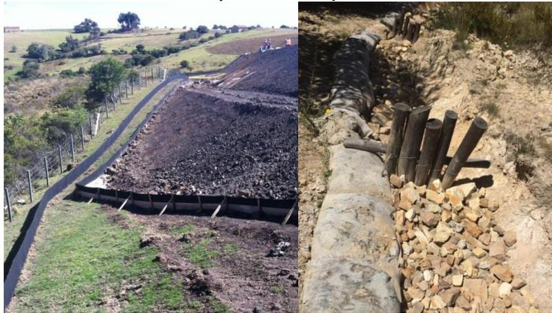
Construcción de barreras sedimentadoras y trinchos tipo en las locaciones
