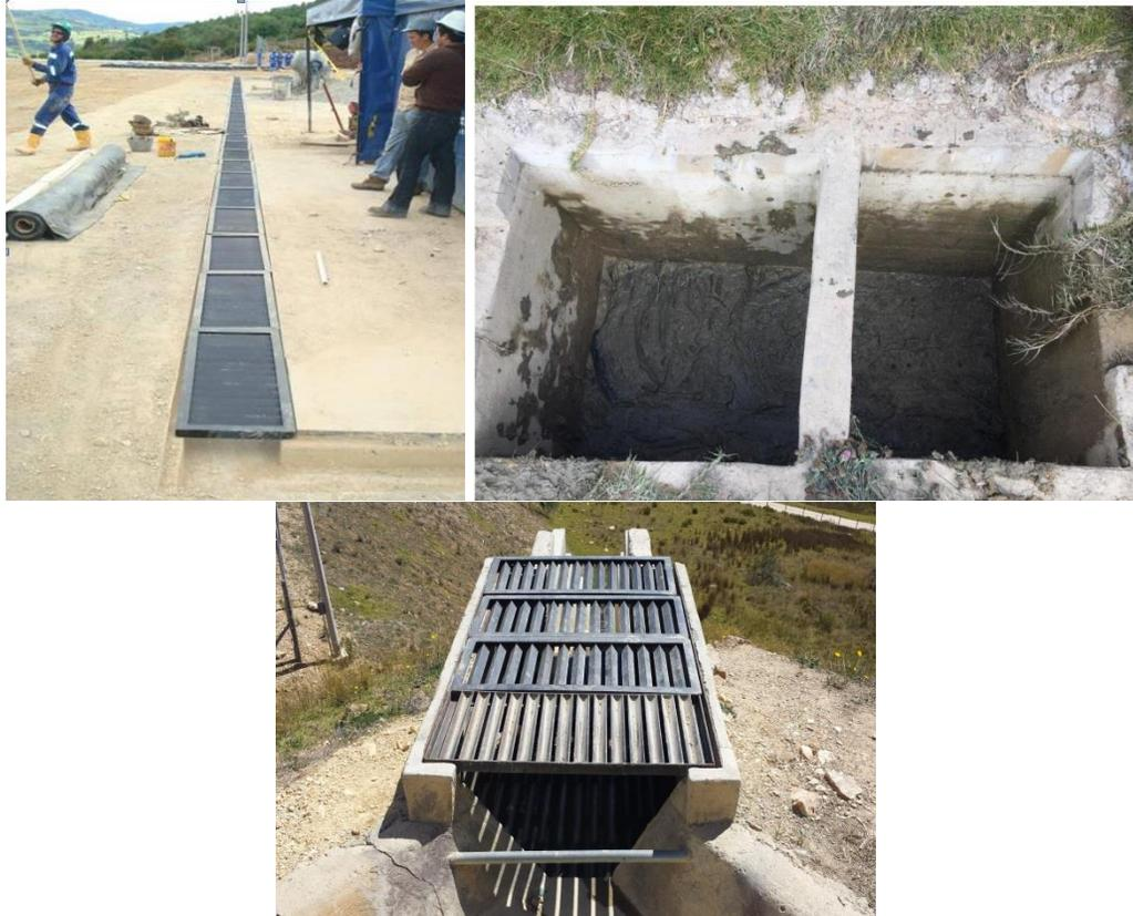
**Construcción de canal perimetral en torno a la placa donde se instalará el taladro; Caja de separación de la fase líquida sólida y aceitosa; Skimmer**
